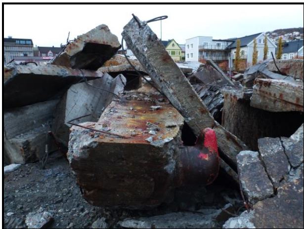
Betongelementer tatt opp – 250 tonn
