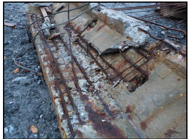
Betongelementer med armering og asfalt
