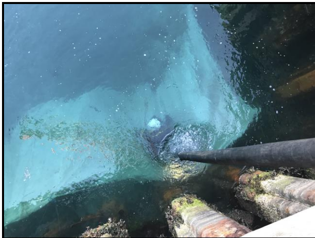
Utstøping ved bruk av dykker
